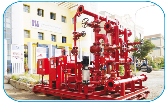
مجموعة مضخات البنك الأهلي المصري UL/FM pump skid project
